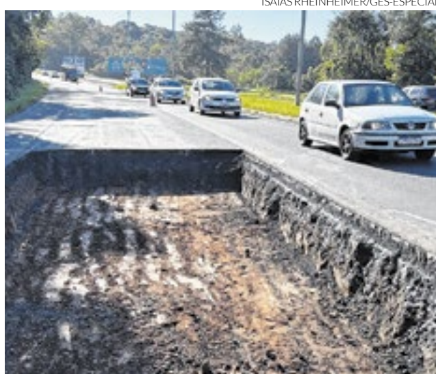
Obras ao longo de 1,5 quilômetro provocaram bloqueios
