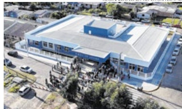
Prédio da Emei tem 1,2 mil metros quadrados
