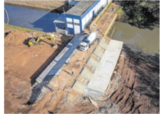
Obra de reforço do dique está entrando na fase final
