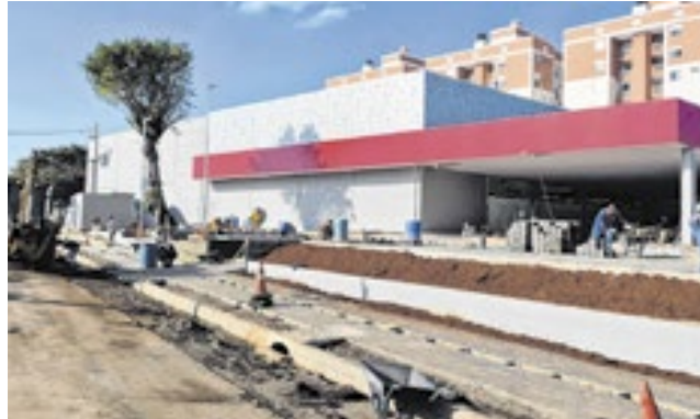
Obras no Rissul Esteio estão nos detalhes finais
