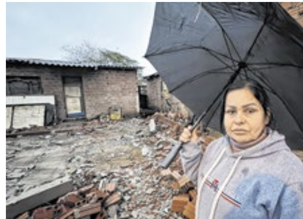
Daiana no local onde ficava a garagem demolida
