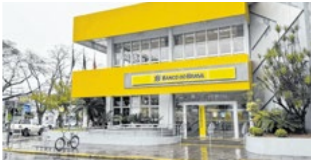
Agência foi invadida por buraco na parede no domingo
