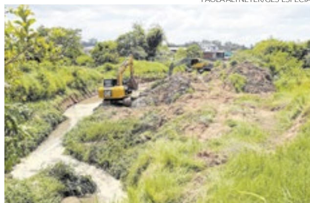
Obras de desassoreamento do Arroio Wiesenthal
