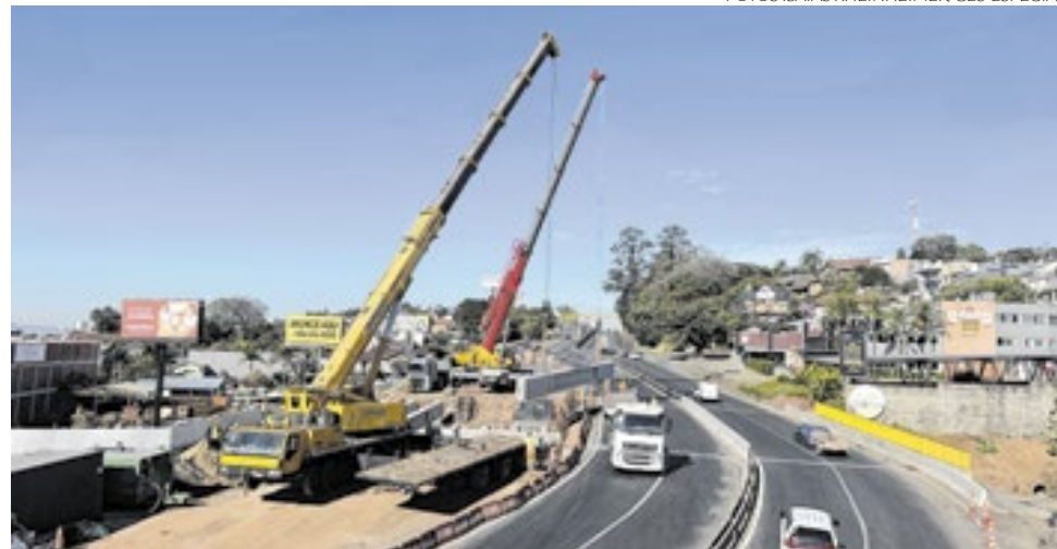
Vigas pré-moldadas de 20 toneladas foram içadas sobre a BR-116 por dois guindastes
