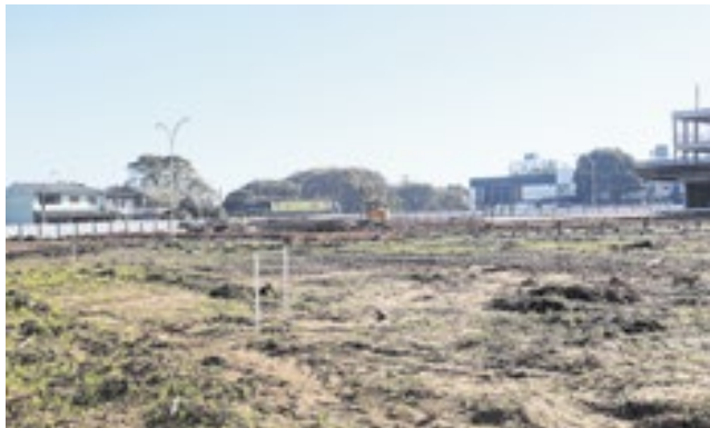
Obras do hospital da Doctor Clin em São Leopoldo
