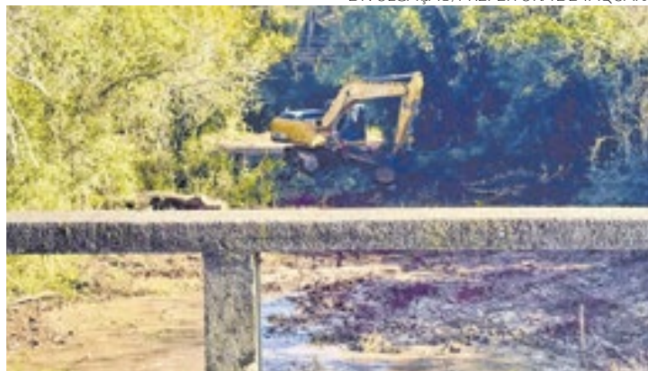
Limpeza junto da Ponte Seca, próximo ao Rio dos Sinos, na RS-020
