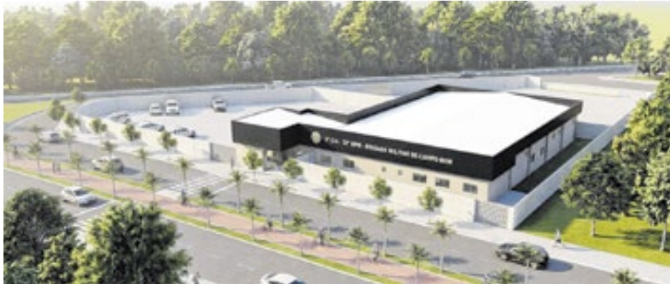
Campo Bom inicia construção do Centro Integrado de Segurança Pública
