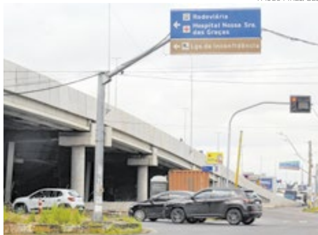
Viaduto da Metrovel está em obras desde abril de 2025
