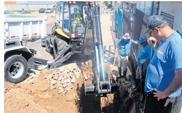
Manutenção de vazamento oculto realizado pela Comusa
