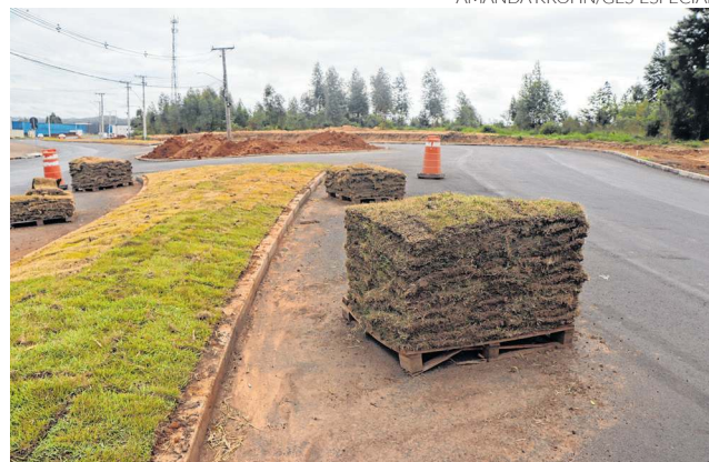
Ajardinamento faz parte dos detalhes finais da obra
