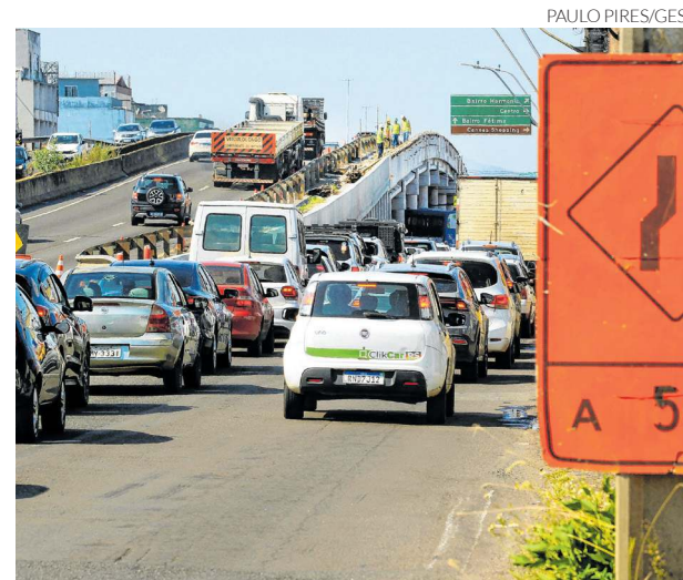
Já é possível ver parte da obra quase pronta
