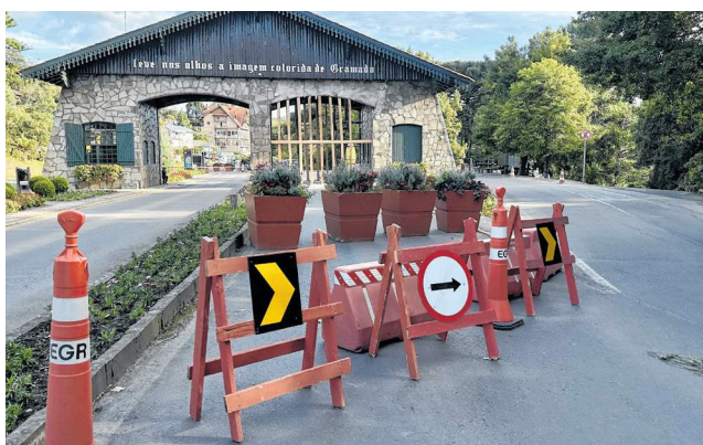
Trânsito está sendo direcionado às pistas laterais da rodovia
