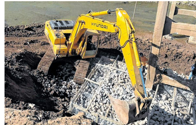
Serviço é feito na ponte na Rua José Fernando Hartmann
