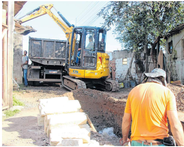
ISAÍAS RHEINHEIMER/GES-ESPECIAL Serão instalados cerca de 150 metros de rede pluvial
