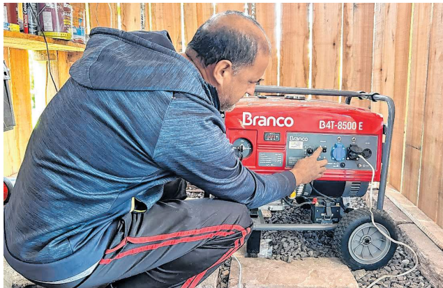
Com falta de luz há dias, Paulo comprou um gerador
